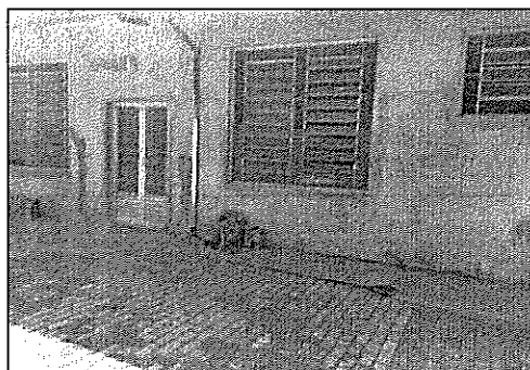
Vista da entrada lateral
