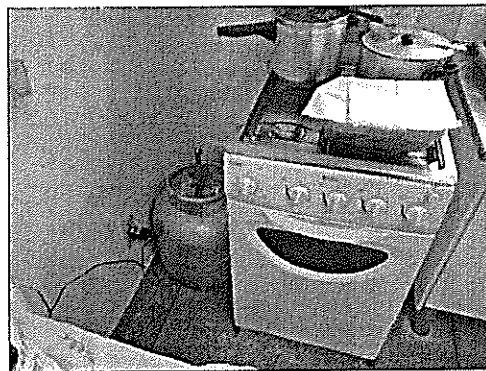
Bolijão de gás na cozinha da USF
